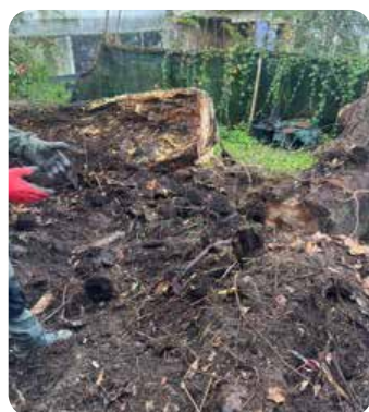
Pulizia del terreno morto
